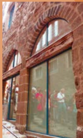
Un bel exemple de construction postérieure sur des arcs romans conservés avec leur poutre d'origine typique, en bois.
