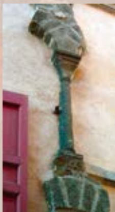
Un exemple de colonnade centrale d'une salle romane réutilisée comme support d'un mur de séparation.
